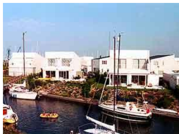
Insteekhaven met woningen
