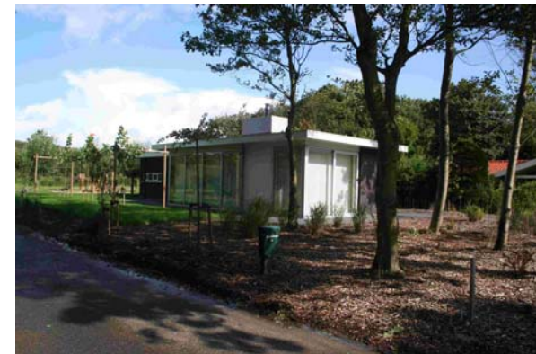
Nieuwere bungalow, goed ingepast in planopzet.
