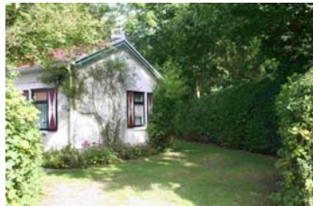
Voorbeelden van originele woningen
