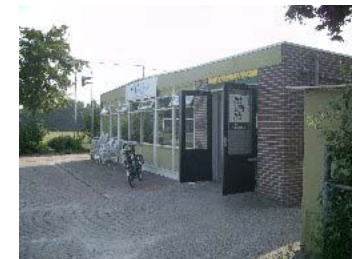
Voorzijde van sportgebouw in Colijnsplaat gericht op binnenterrein.
