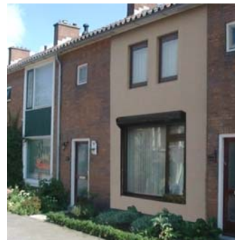
Niet passend door afwijkend materiaal- en kleurgebruik.
