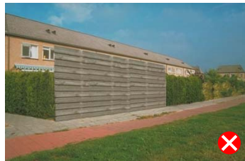
Erfafscheiding te hoog en uitgevoerd in inferieure materialen.
