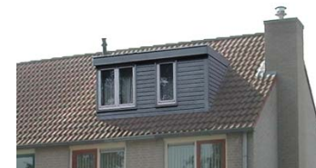
Niet passend door afwijkend materiaal- en kleurgebruik.
