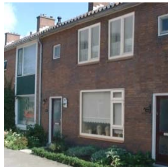
Niet passend door afwijkende indeling.
