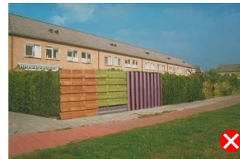
Niet passend door onsamenghangend materiaal- en kleurgebruik.
