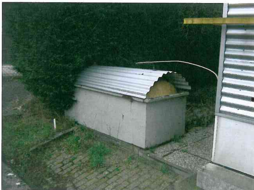
Foto IMG_2362, Verdachte deellocatie 2. Huidige bovengrondse HBO-tank gezien in oostelijke richting. Peilbuis 4 (op foto links naast de tank) uit onderzoek SGS uit 2001 nog aanwezig.
