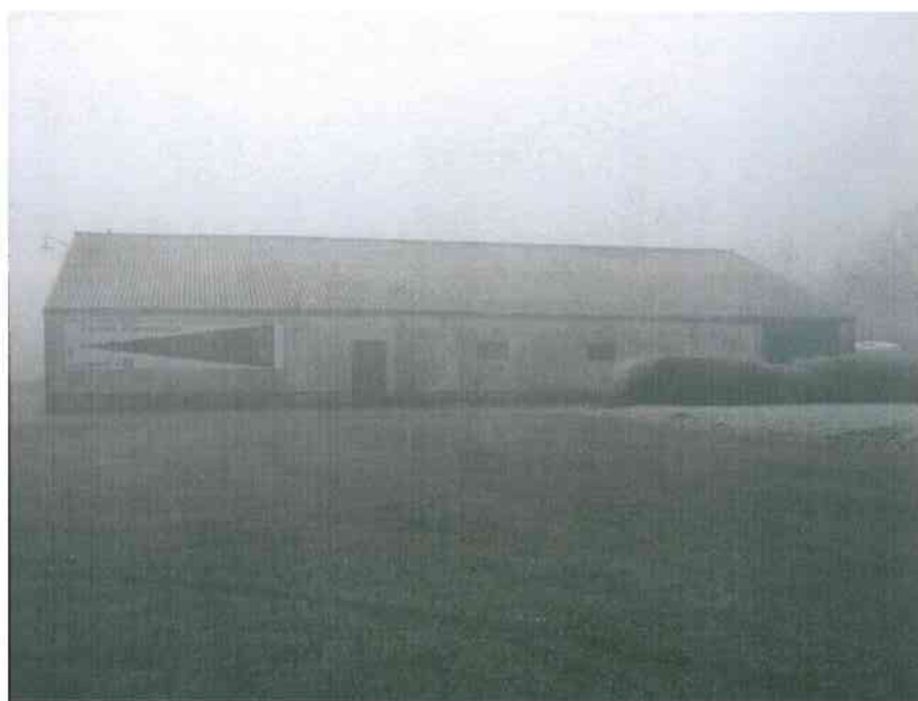
Foto IMG_2328, Deelgebied 4 gezien in zuidwestelijke richting met rechts op de foto het onverharde deel van de locatie.
