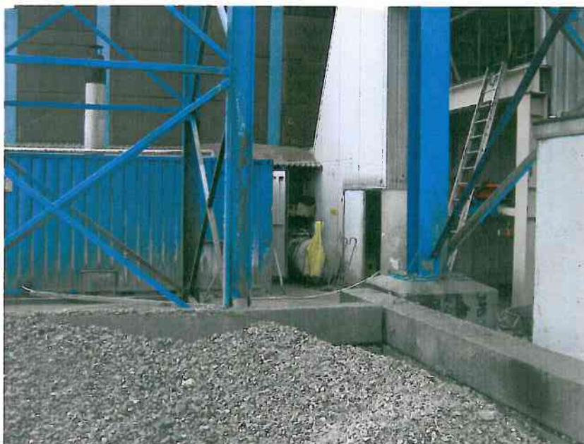
Foto IMG_2359, Verdacht deellocatie 10. Huidige dieseltank (mortelfabriek) gezien in noordwestelijke richting. Tank rechts van blauwe container aanwezig. Ter plaatse is een sterke verontreiniging met minerale olie en vluchtige aromaten in grond en grondwater aangetroffen.
