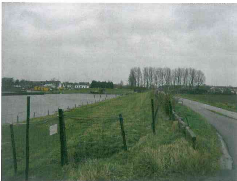
Foto IMG_2364, Deel van deelgebied 3 gezien in noordoostelijke richting. Op de berm van de dijk heeft het voormalige pad gelegen wat mogelijk (half)verhard is geweest.
