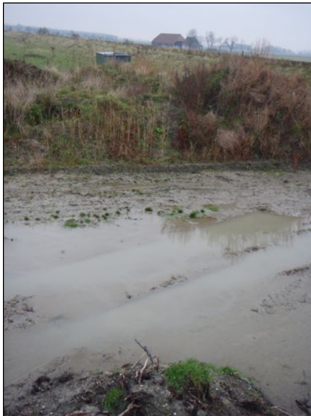
Afbeelding 2.1 Gronddepot met plasvorming.
