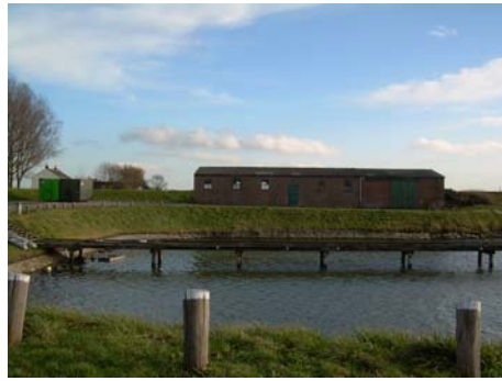
Oude opslagloods in handelshaven (oostzijde)
