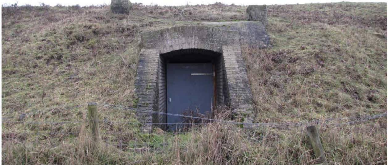
Figuur 10: Een van de 2 bunkers waar vleermuizen gemonitord worden
