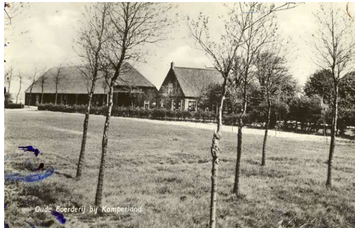
Bouw e Plantlust 1960
