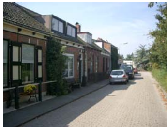
Fraaie gevelwand met stoep-palen aan de voorzijde.
