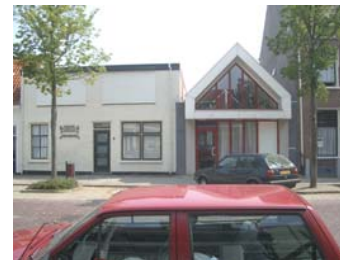
Gebouw met platdak en hedendaagse interpretatie van bestaande typologieën in Wissenkerke.
