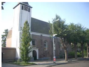
De Hervormde kerk vormt de beëindiging van de Voorstraat.
