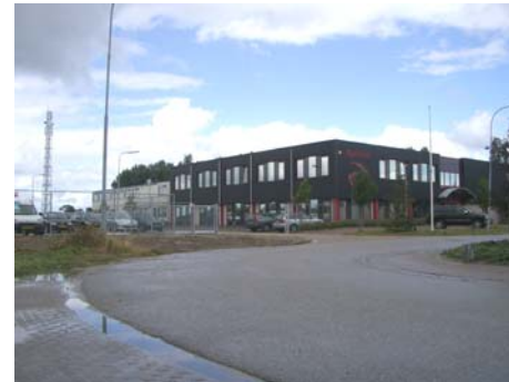
Kantorencomplex van twee bouwlagen met gecombineerd materiaalgebruik in de gevel.
