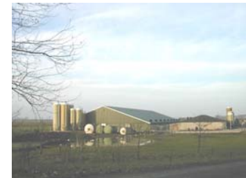
Loodsen en silo's zijn karakteriserend voor de veeteelt.
