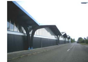
Fraaie constructie van de bedrijfsbebouwing in de haven van Kortgene.
