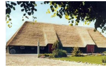
Schuur met schilddak en lage zijgevels. Het dakvlak is bij de mendeuren opgelicht.
