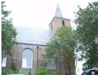
Kerkgebouw onderaan de dijk in Kortgene vormt het beeld vanaf de Hoofdstraat.
