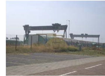
Beeldbepalende kranen op het industrieterrein bij Kats.
