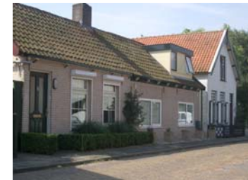
Opvallende gevelindeling in de langsgevel aan de Westkruisstraat.
