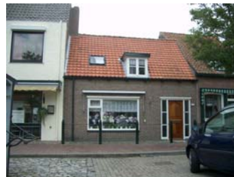
Gesloten gevelwanden met afwijkende bebouwing in kleur en vormgeving.
