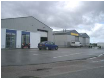
Loodsen met kantoorruimte aan de straatzijde in Kamperland.
