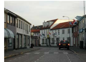
Gesloten gevelwand van de Kaaidijk.
