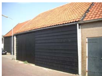
Karakteristieke houten gevelbekleding Colijnsplaat.
