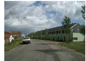
Opvallend kleurgebruik aan de Toredijk in Kortgene.
