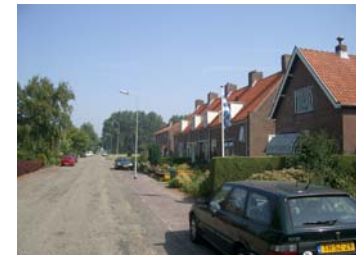
Geschakelde woningen aan de Geersdijkseweg.
