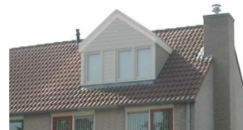
Vormgeving sluit niet aan op de stijl van de woning.
