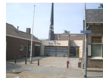
Teruggelegen rooilijn zorgt voor een pleinvormige ruimte in Wissenkerke
