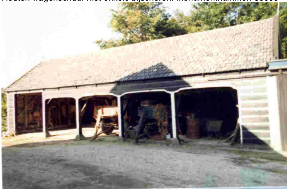
Houten wagenschuur met enkele bijschuren. Monumentnummer: 39095
