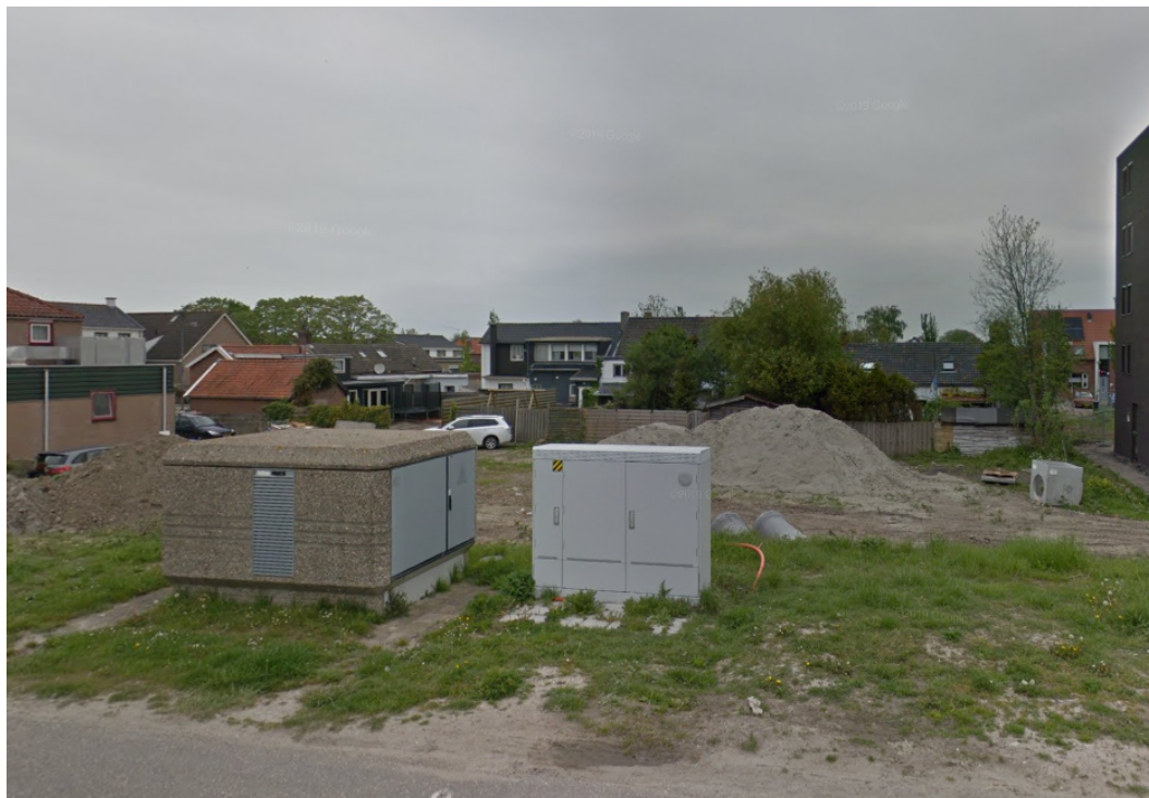
Figuur 2.1: Zicht op het plangebied vanaf de Oosthavendijk
