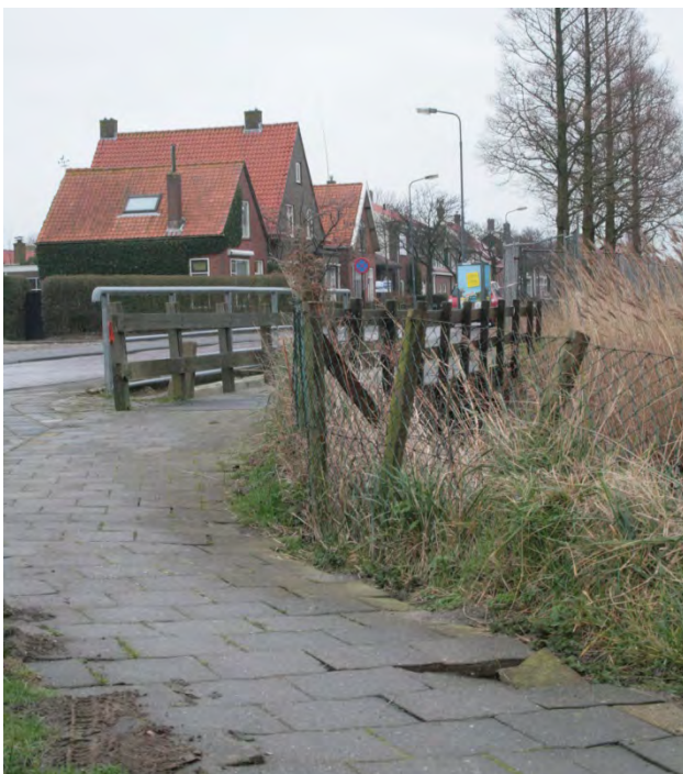
Afbeelding 31 verzakkingen in de stoep
