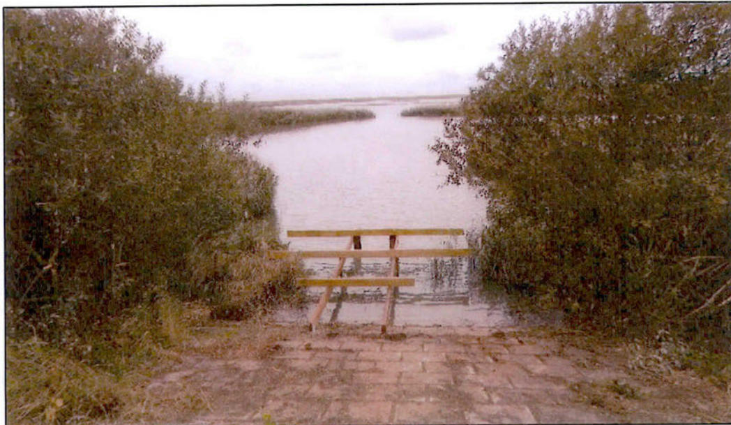
Afb.3 Vogelhut in aanbouw, november 2017.
