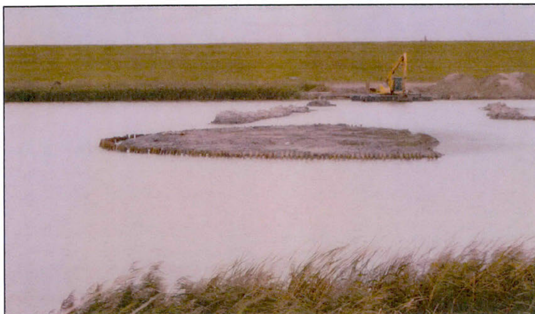
Afb.1 broedeiland in de 's Gravenhoek in aanbouw.
