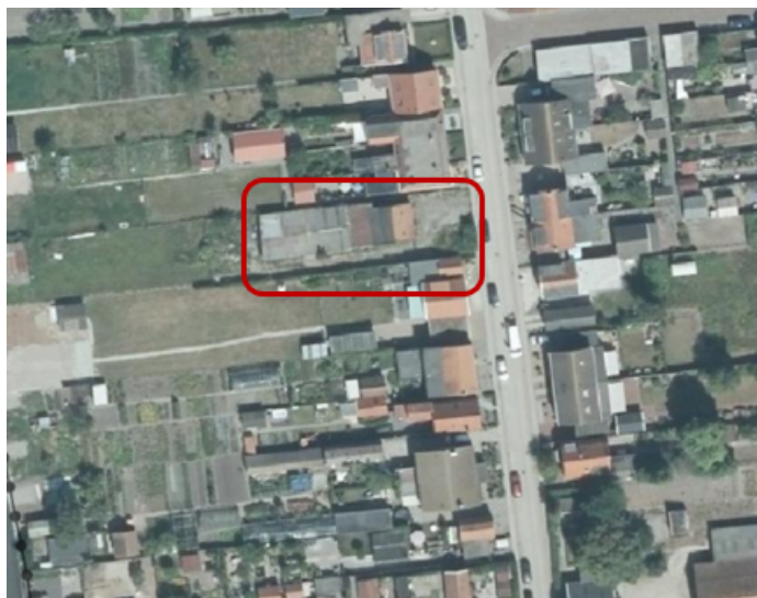
Figuur 2.4: schuur aan de West-Havenstraat 9a
