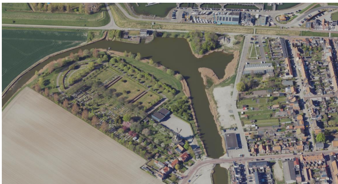
Figuur 4.4: Luchtfoto van de Valkreek. De historische structuur is alhier goed bewaard gebleven. Deze waterloop wordt begeleid door natuurlijke oevers, wat het aanzicht en de kwaliteit van deze waterloop versterkt.
