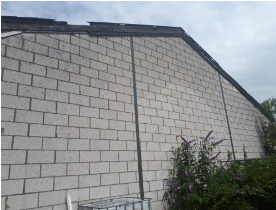
Kopgevel aan de zuidzijde van de opstal. Foto: J. Keyzer| Ecoresult B.V.
