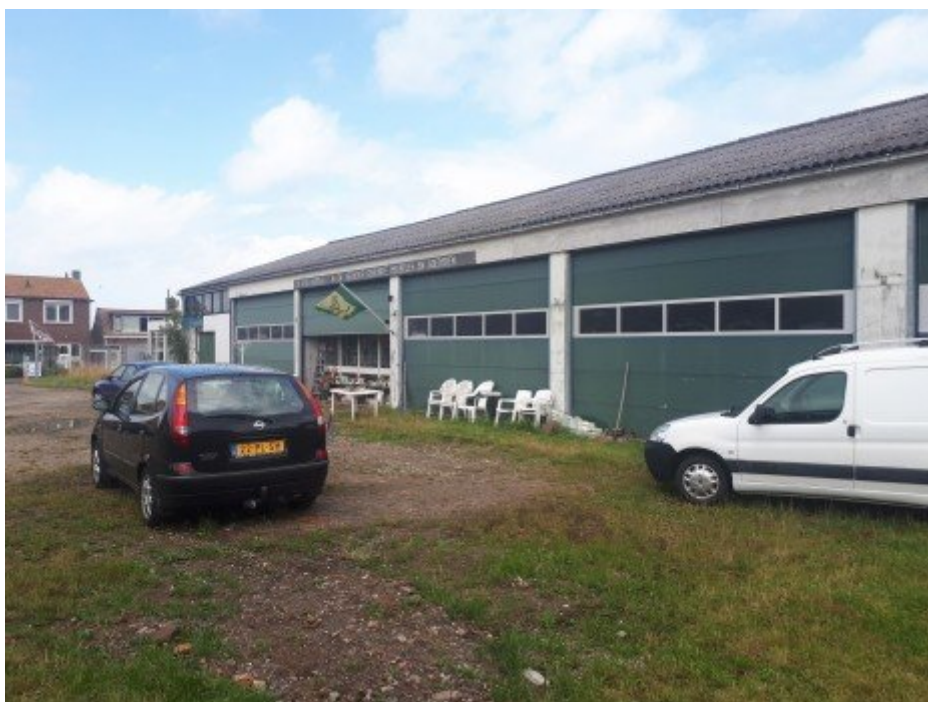
Lange zijde van de opstal met garagedeuren. Foto: J. Keyzer| Ecoresult B.V.
