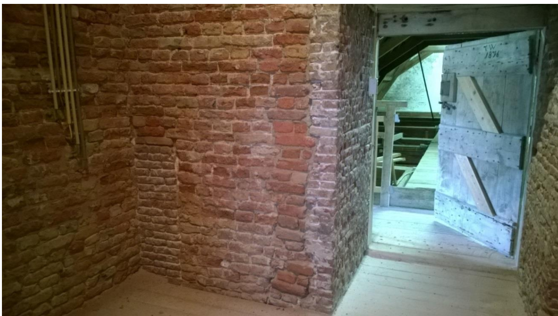
In moppen uitgevoerd metselwerk van de toren met linksonder een dichtzetting in kleinere steen in Lange Vecht formaat. De doorgang naar de kerkkap is afgewerkt in hergebruikte steen van een ander formaat.
