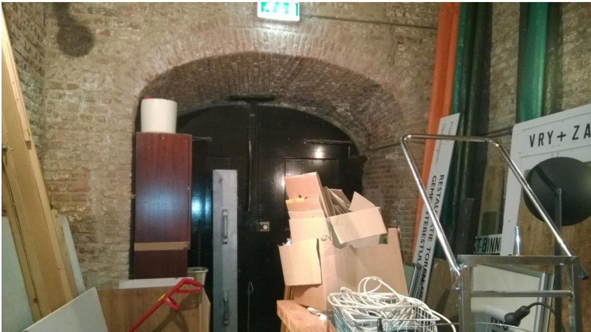
Entree van de toren, aangepast in kleinere steen. Elders de oorspronkelijke 15 e eeuwse moppen.
