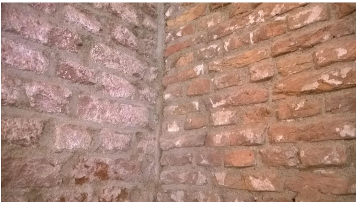
Detail aansluiting dichtzetting rechts en torenwand links.
