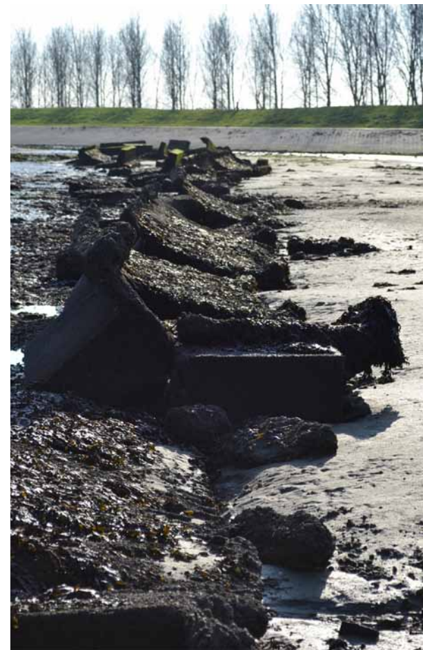
'Gebroken diek' tussen Kattendijke en Goese Sas.
