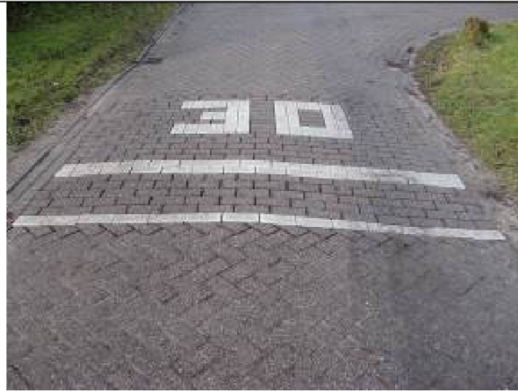
Figuur 1. Uitritconstructie met inritblokken en doorgaand trottoir (voor dwarsprofiel A-A zie figuur 2)
